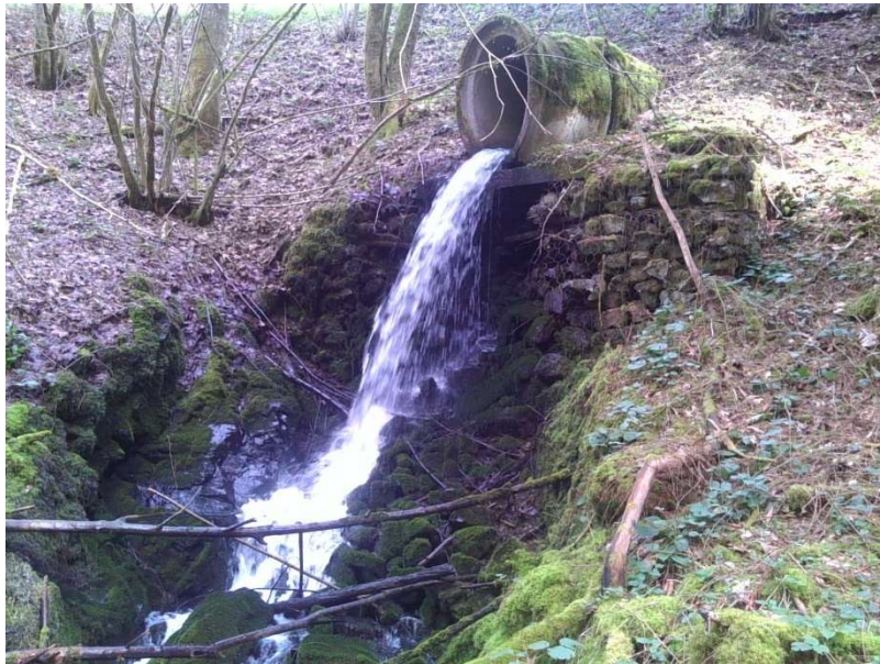
Figure 29 : buse infranchissable sur le ruisseau des écrevisses
