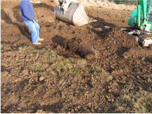
Déroulement de la plaque de chaume sur le lit de dépose
