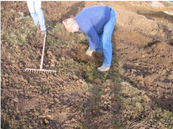
=> et pour terminer : opération importante... : la finition des joints avec les excédents de terre
