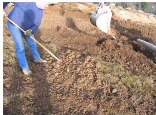
Préparation manuelle du lit de dépose (couche de terre)
