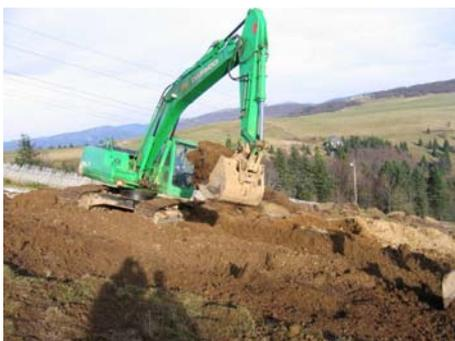
Transfert des plaques enroulées de la zone de dépôt (géotextile) vers l'emplacement de réimplantation
