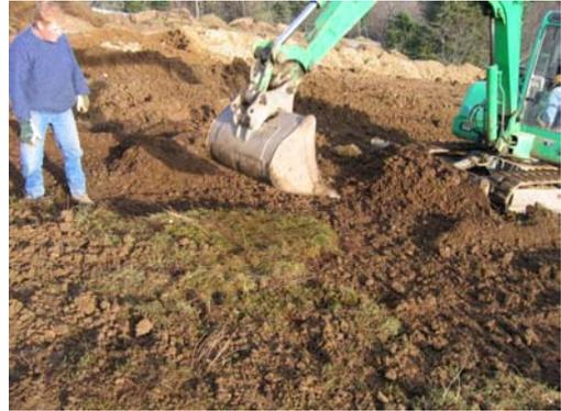
Avec godet : mise en place définitive, pression modérée pour mettre en contact la plaque de chaume au plus près du lit préparé
