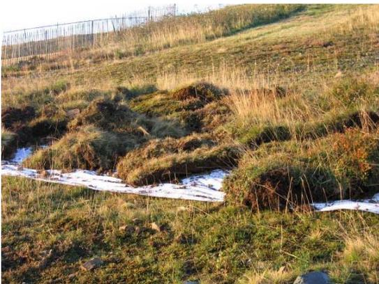
=> Les plaques de chaume ainsi découpées restent entreposées sur le géotextile pendant la durée des travaux d'aménagement (1 mois dans le cas présent sur le stade du slalom)
