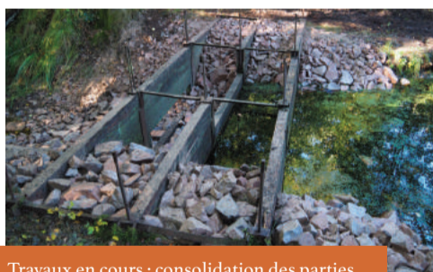
Travaux en cours : consolidation des parties latérales de l'ouvrage.
